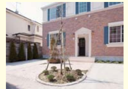
プリマレジデンス武蔵野(東京都小金井市)
